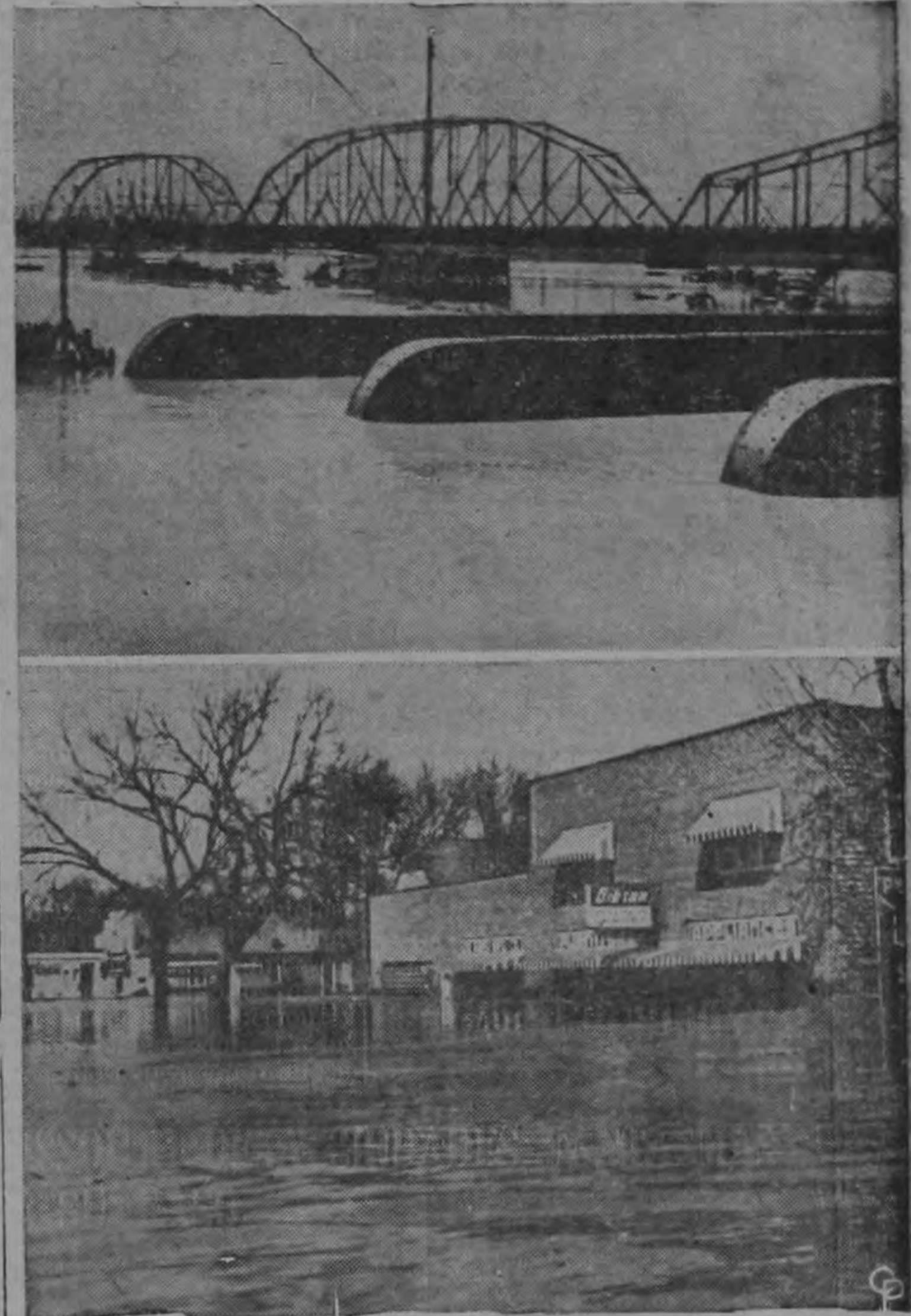
El río Missouri pasa por sobre los puentes del Ferrocarril Northwestern en Sioux City, Iowa, mientras las crecidas aguas del río inundan las tierras vecinas. Abajo, la calle principal de South Sioux City Nebraska, aparece bajo dos metros y medio de aguas barrientas. La foto fué tomada desde un bote de salvamento de los guardacostas que navegaba por el corazón de la ciudad. (INP).
